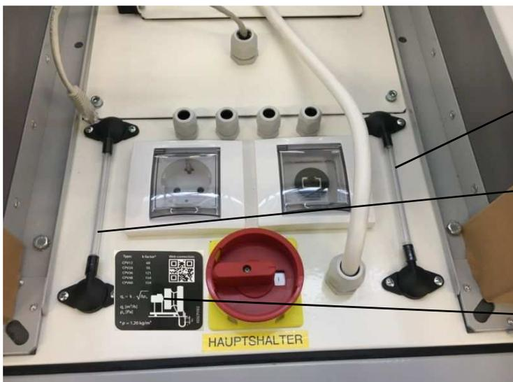
Sonde zur Messung des Differenzdrucks des **Zuluftventilators**
